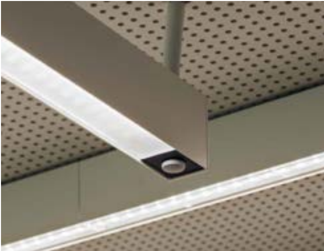
Institut Vilablareix, Girona 2022. Infinite luminaires with Stand Alone sensor, configured with the Ready To service based on the customer's control needs. Luminaires Infinite avec capteur autonome Stand Alone, configurés à l'aide du service Ready To, selon les besoins de contrôle de présence du client.
